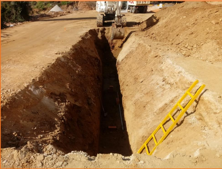
Foto 5. Seguiment excavació del segon tram de rasa.
