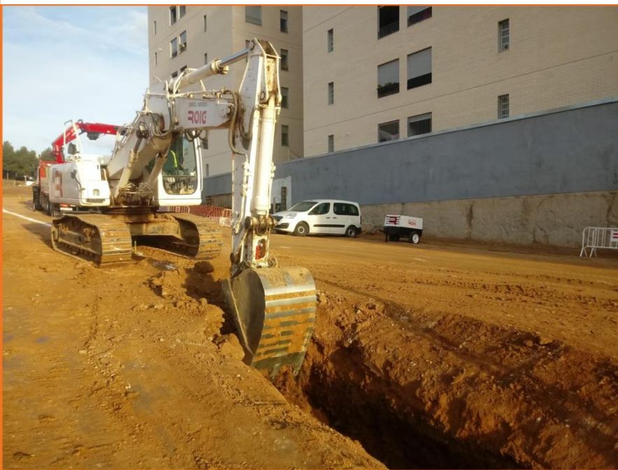
Foto 2. Inici del rebaix del primer tram de rasa.
