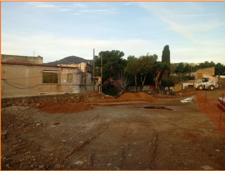
Foto 1. Vista general abans de l'inici de l'obertura de la rasa.
