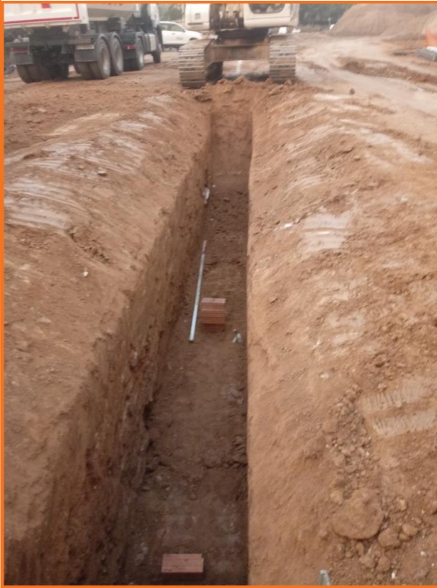
Foto 3. Seguiment excavació del primer tram de la rasa.
