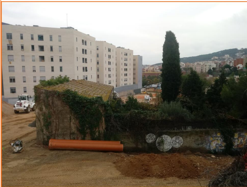
Foto 6. Vista general de la casa a enderrocar.
